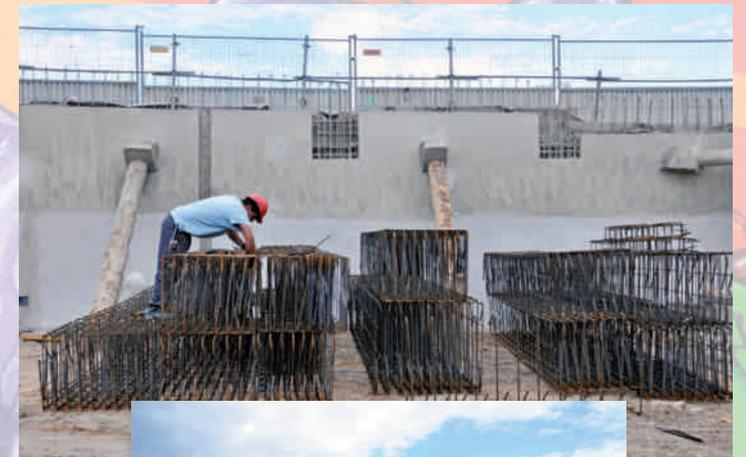
Des grilles d'acier sont en attente d'être installées dans les puits de fondation creusés à une profondeur suffisante. Ils vont recevoir du gros béton. Une technique semi-profonde qui permet d'assurer une stabilité et une portance du futur bâtiment.
