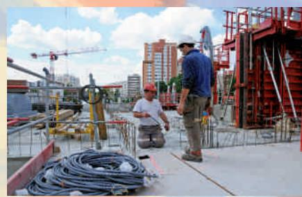
Sur ce chantier tout en longueur, les travaux ont été réalisés en deux phases. Sur cette partie, au niveau du parking, reste à couler le dallage, le plancher haut du sous-sol et du rez-de-chaussée pour se retrouver au niveau de la rue. On distingue les parois moulées maintenues par des butons sur la rue Pierre Timbaud. De l'autre côté de la parcelle, les murs sont en train d'être montés.
