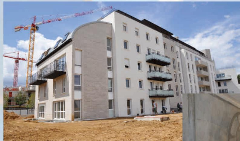
Un auvent en béton assure une protection contre le soleil en été tandis que de larges baies vitrées laissent entrer la lumière naturelle dans les pièces à vivre, ce qui permet de chauffer au minimum l'hiver.
