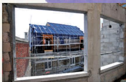
La charpente en bois traditionnel permettra d'aménager les combles. Les câbles réseaux sont en attente d'être installés dans chaque appartement. On aperçoit les lucarnes en saillie (qui dépassent de la façade). Réalisées en structure bois, elles seront peintes plus tard. La coursive basse a reçu sa chape de béton.
