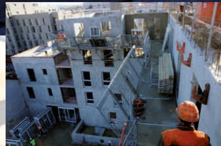
Le corps de bâtiment s'élève sous un beau ciel bleu d'hiver. Les cinq niveaux sont réalisés. Les ouvriers vont attaquer la terrasse. Les châssis des fenêtres sont posés. Les câbles et gaines ont été tirés à l'intérieur des planchers, des murs et des cloisons.
